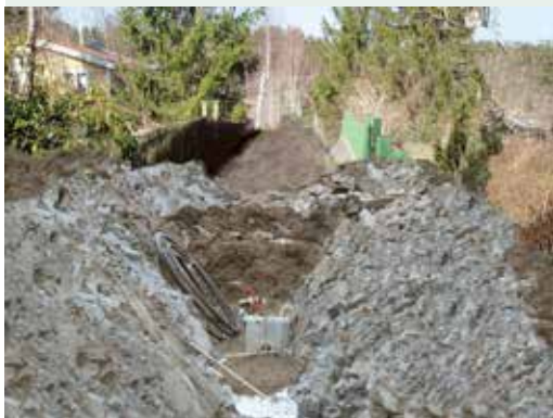
Sama katu kuin edellä, kaivettuna täyteen syvyyteen
